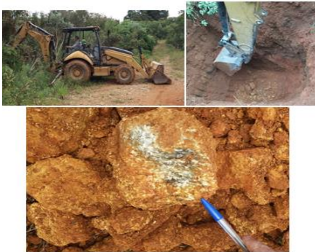
Figura 9 – Escavação do PÇ-01.
